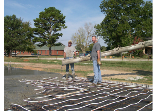
POUR AND FINISH CONCRETE
