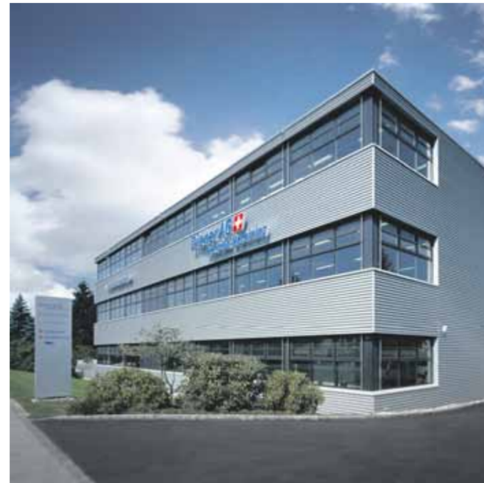
Einer der Marktführer bei Präzisionspumpen, Firmensitz von Diener// One of the leading brands in precision pumps, headquarters of Diener
